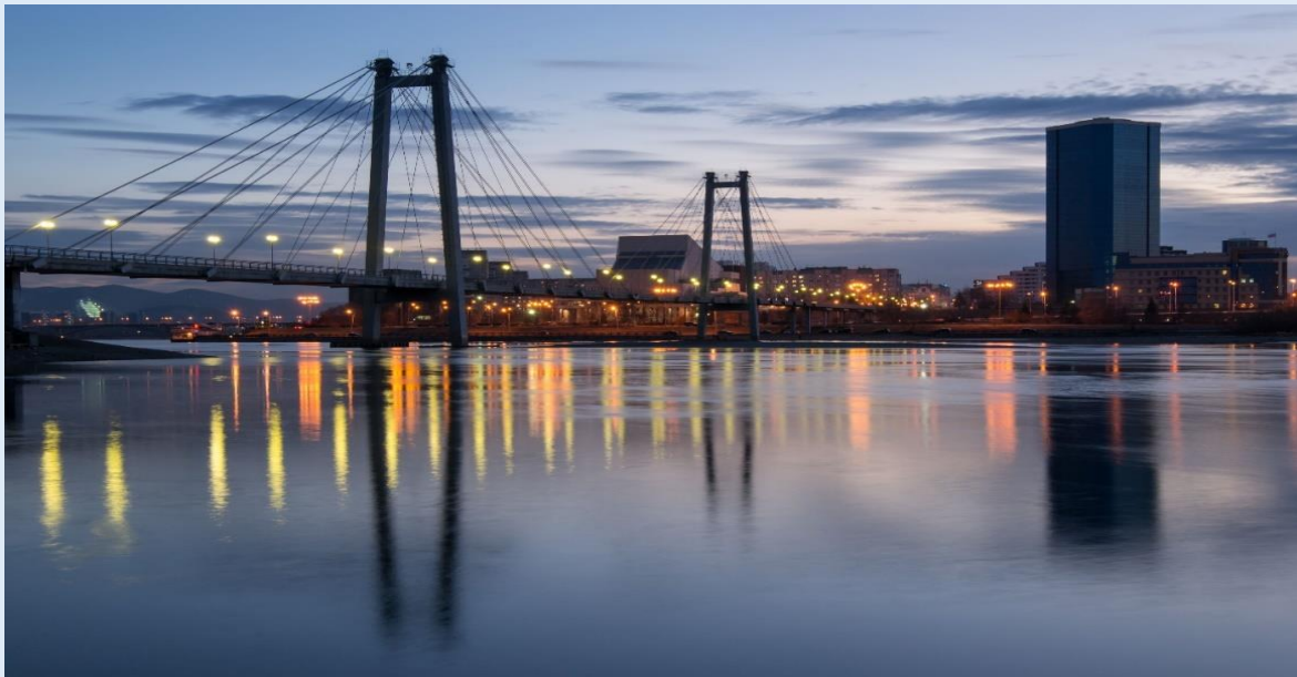
Brücke über Jenissei in Krasnojarsk
